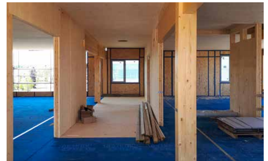
De constructieve schijven van het gebouw bestaan uit CLT, geproduceerd met vurenhout uit FSC/PEFC-gecertificeerde bossen. Andere gevels zijn opgetrokken in houtskeletbouw.
