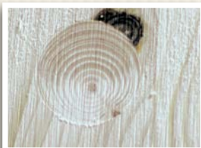
gebruikelijke deuvelverbinding
